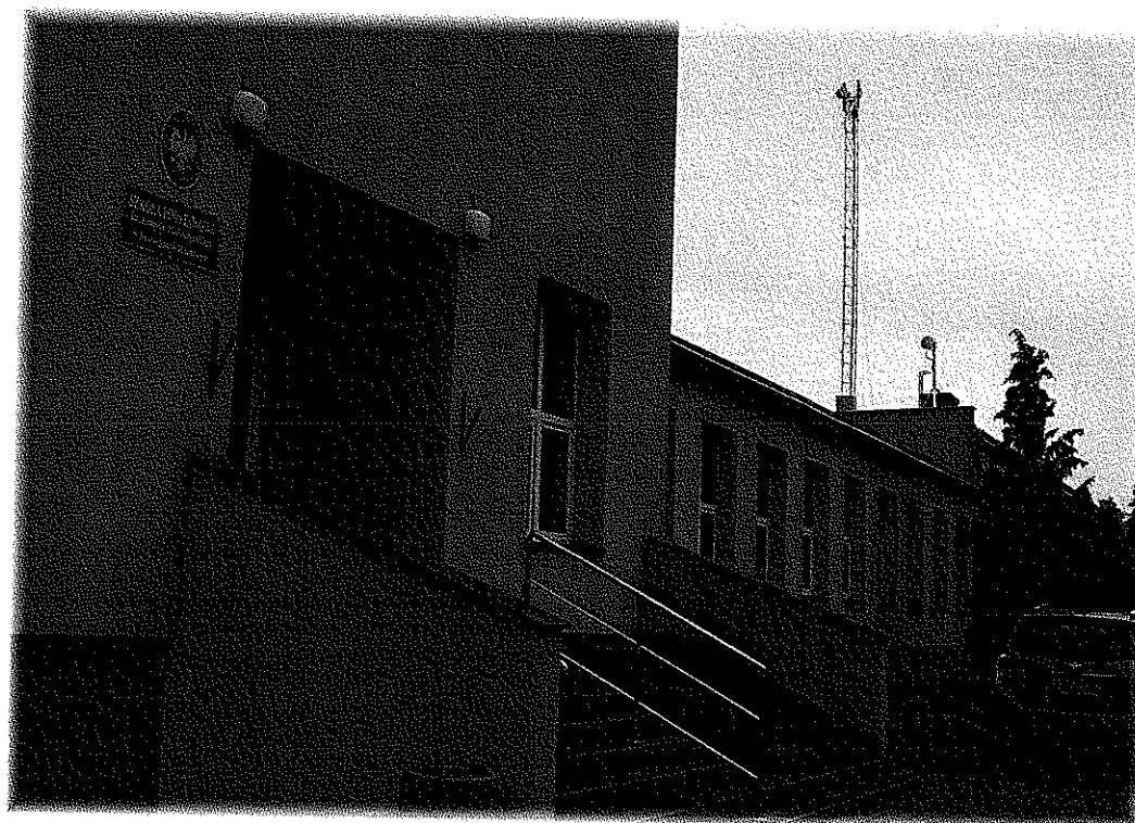
Fot. 1. OM Starorypin Rządowy 13 – widok budynku z anteną linii radiowej Emitel
